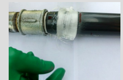
Glasfaserband ca 5 cm lang abschneiden, in die vorbereitete Kleberschicht einlegen und leicht andrücken.
