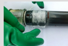
Ein wenig warten, bis das Material beginnt zu reagieren, dann Vorgang wiederholen (Kleber auftragen, zweites Glasfaserband einlegen)
