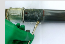
!zweite Lage nur erforderlich bei größeren Löchern! Reparaturstelle über die Ränder des Glasfaserbandes hinaus, mit friko-dichtspachtel einstreichen
