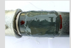
Aushärten lassen, nach ca. 60 Minuten ist das Rohr wieder belastbar
