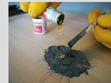
Kleine Menge friko-dichtspachtel abmischen und mit Pinsel/Spatel „satt“ auftragen (Mischbehälter liegt dem Produkt bei)
